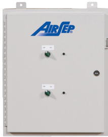
Módulo compresor de aire
