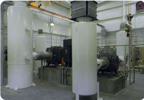
进排气消音器
