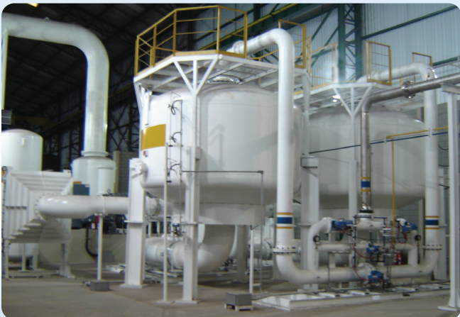
某钢铁厂的两台 ASV80000 VPSA 制氧装置 — 巴西马拉巴
