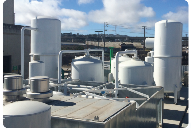
废水处理设施处的两台 ASV45000 VPSA 制氧装置 — 美国加利福尼亚州旧金山
