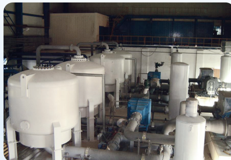
Deux installations d'oxygène VPSA ASV33000 dans une mine d'or – Kazakhstan
