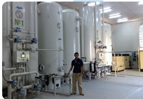
Installation d'oxygène médical duplex PSA AS-Z5500-HM – Paraguay
