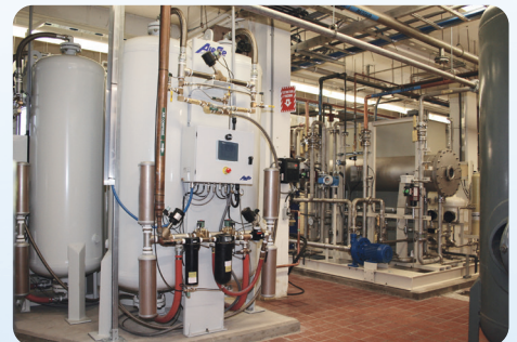
Installation d'oxygène triplex PSA AS-L1000 pour la production d'ozone – Saint-Jean, Québec, Canada
