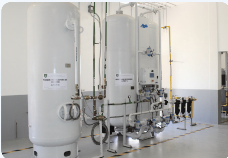
Installation d'oxygène médical duplex PSA AS-Q2600-HM – Nicaragua
