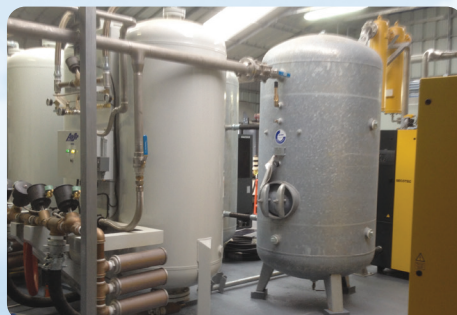
Installation d'oxygène PSA AS-P2000 (OXYMAR) par OXZO S.A.) pour la pisciculture – Chili
