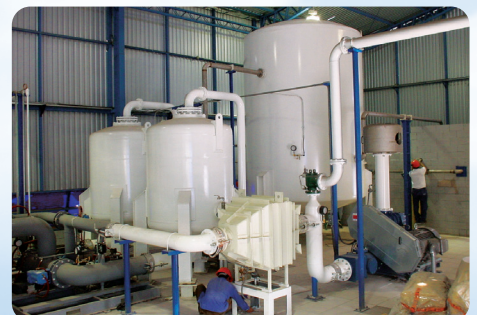
Installation d'oxygène VPSA ASV14500 dans une aciérie – Salvador
