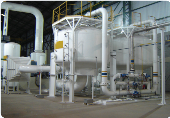
Deux installations d'oxygène VPSA ASV80000 dans une aciérie – Brésil
