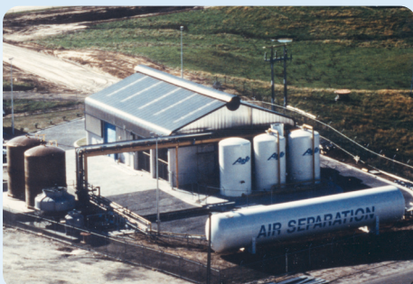
Installée et en service depuis 1991 dans une usine de pâte à papier et de papier, cette installation d'oxygène PSA de 42 TPD fournit du gaz pour le blanchiment et la délignification.
