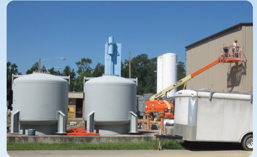
Mise en service d'une installation d'oxygène VPSA ASV27000 dans une usine de traitement des eaux usées – Rocky Mount, NC, États-Unis
