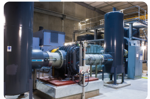
Deux installations d'oxygène VPSA ASV39000 pour la production d'ozone – Melbourne, Australie
