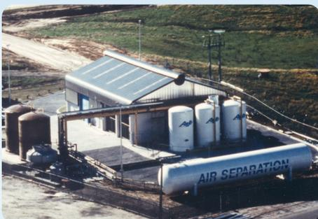
Instalada y en funcionamiento en una fábrica de celulosa y papel desde 1991, esta planta de producción de oxígeno PSA de 42 TPD suministra gas para blanqueo y deslignificación.
