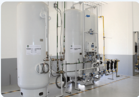
Instalação de oxigénio médico PSA Duplex AS-Q2600-HM – Nicarágua
