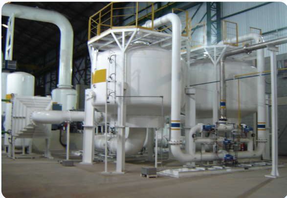
Duas instalações de oxigénio VPSA ASV80000 numa fábrica de aço – Brasil
