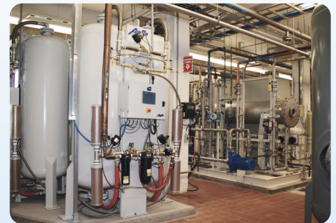
Instalação de oxigénio PSA Triplex AS-L1000 para geração de ozono – St. Jean, Quebec, Canadá
