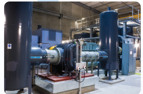
Duas instalações de oxigénio VPSA ASV39000 para a geração de ozono – Melbourne, Austrália
