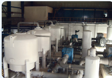
Duas instalações de oxigénio VPSA ASV33000 numa mina de ouro – Cazaquistão
