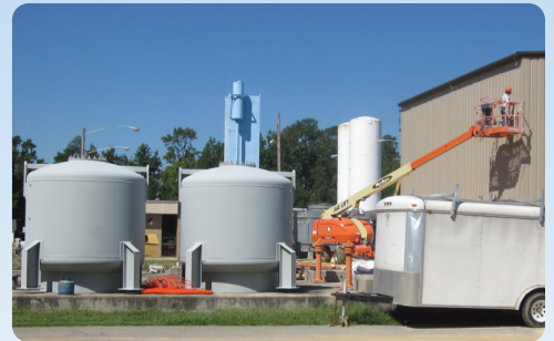
Arranque de uma instalação de oxigénio VPSA ASV27000 numa estação de tratamento de águas residuais – Rocky Mount, NC, EUA
