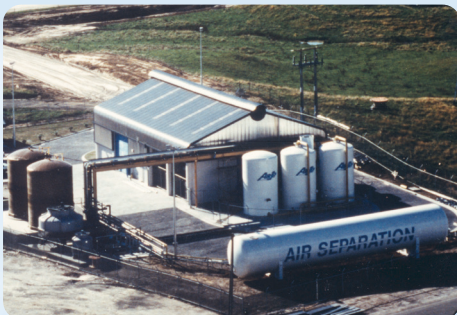
Instalada e a operar numa fábrica de papel e celulose desde 1991, esta instalação de oxigénio 42 TPD PSA fornece gás para branqueamento e deslenhificação.
