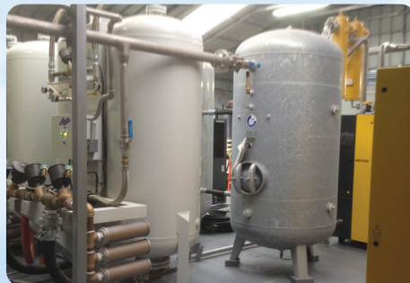
Instalação de oxigénio PSA AS-P2000 (OXYMAR – pela OXZO S.A.) para piscicultura – Chile
