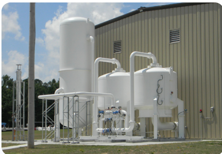
Instalação de oxigénio VPSA ASV27000 numa estação de tratamento de águas residuais – Rocky Mount, NC, EUA
