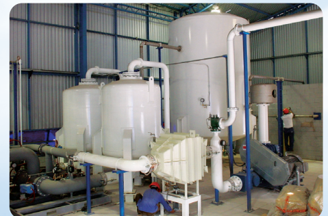
Instalação de oxigénio VPSA ASV14500 numa fábrica de aço – El Salvador
