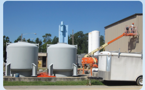
在废水处理设施处启动 ASV27000 VPSA 制氧装置 — 美国北卡罗来纳州落基山
