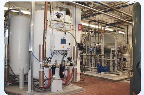
用于产生臭氧的 AS-L1000 三工 PSA 制氧装置 — 加拿大魁北克省圣让
