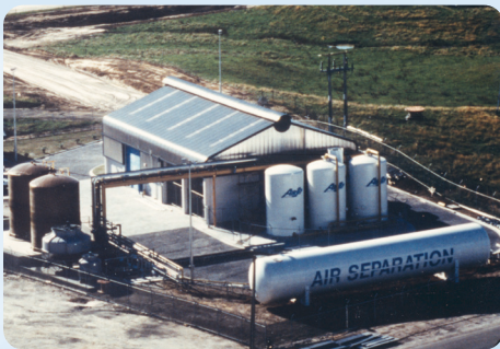
这台 42 TPD PSA 制氧装置自 1991 年以来在一家制浆造纸厂安装并投入运营，为漂白和脱木素供氧。
