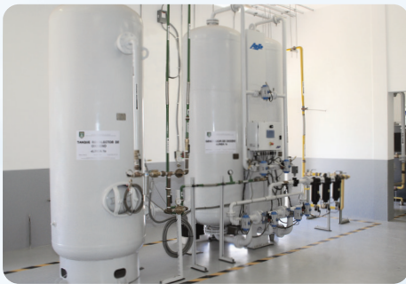
AS-Q2600-HM 双工 PSA 医用制氧装置 — 尼加拉瓜
