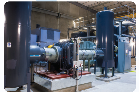
两台用于产生臭氧的 ASV39000 VPSA 制氧装置 — 澳大利亚墨尔本
