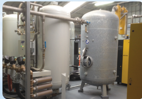
用于养鱼业的 AS-P2000 PSA 制氧装置 (OXYMAR 由 OXZO S.A. 提供) — 智利
