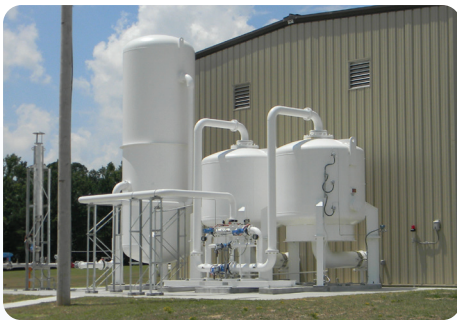
废水处理设施处的 ASV27000 VPSA 制氧装置 — 美国北卡罗来纳州落基山
