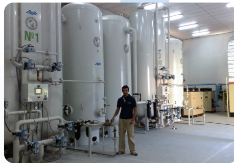
AS-Z5500-HM 双工 PSA 医用制氧装置 — 巴拉圭
