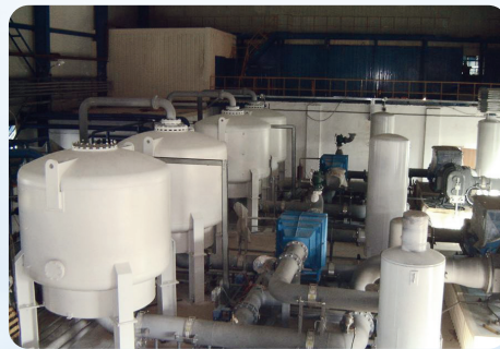
位于某金矿的两台 ASV33000 VPSA 制氧装置 — 哈萨克斯坦
