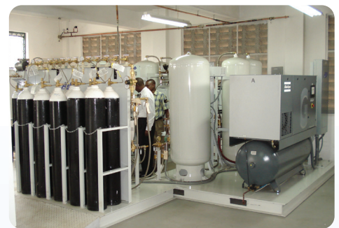
Installation d'oxygène médical duplex PSAAS-J450-HMFM – Kenya
