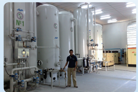
Installation d'oxygène médical duplex PSAAS-Z5500-HM – Paraguay
