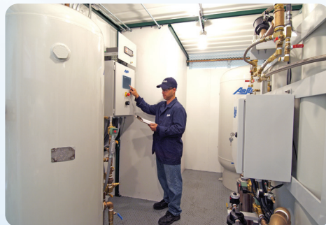
Installation d'oxygène PSA de haute pureté intégrée en conteneurs AS-J250-HPCR pour les forces d'intervention de l'OTAN – Afghanistan
