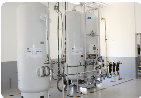
Installation d'oxygène médical duplex PSAAS-Q2600-HM – Nicaragua
