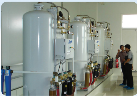
AS-K900-HM 三工 PSA 医用制氧装置 — 中国 三机组
