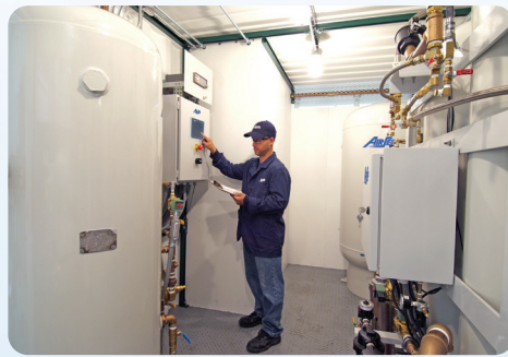
为北约部队提供的 AS-J250-HPCR 集装箱 式高纯度成套 PSA 制氧装置 — 阿富汗
