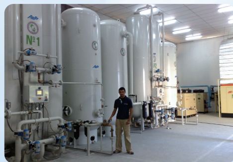
Instalação de oxigênio médico PSA Duplex AS-Z5500-HM – Paraguai
