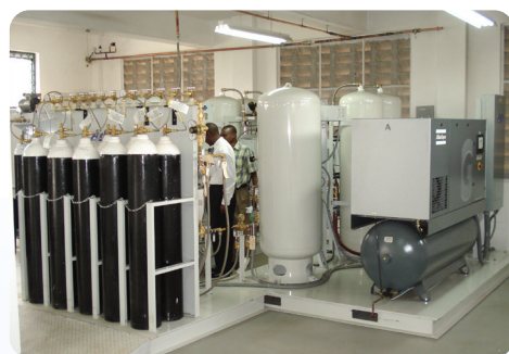
Instalação de oxigênio médico PSA Duplex AS-J450-HMFM – Quênia
