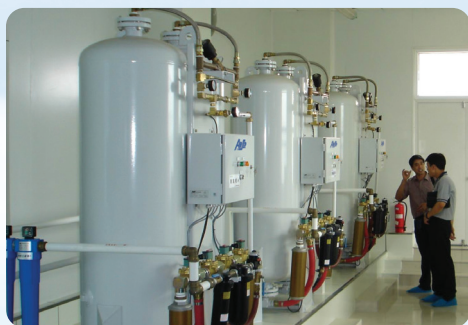
Instalação de oxigênio médico PSA Triplex AS-K900-HM – China
