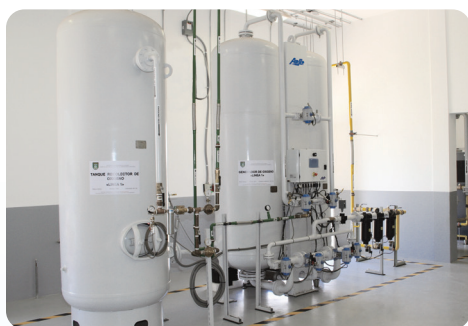
Instalação de oxigênio médico PSA Duplex AS-Q2600-HM – Nicarágua
